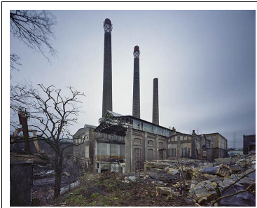
...ein ausgeplündertes und stillgelegter DDR-Betrieb
